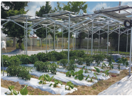
設置場所:岡山大学 農学部 実験農場 日射量を確保するために、太陽光パネルを乱尺に設置しております。
